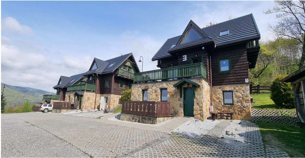
Współczesna zabudowa pensjonatowa nawiązująca do zabudowy tradycyjnej (fot. Andrzej Weigle)
