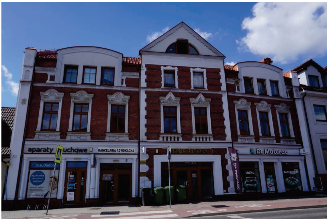
Ryc. 62. Żory – odnowiony budynek przy ul. Dolne Przedmieście 5
