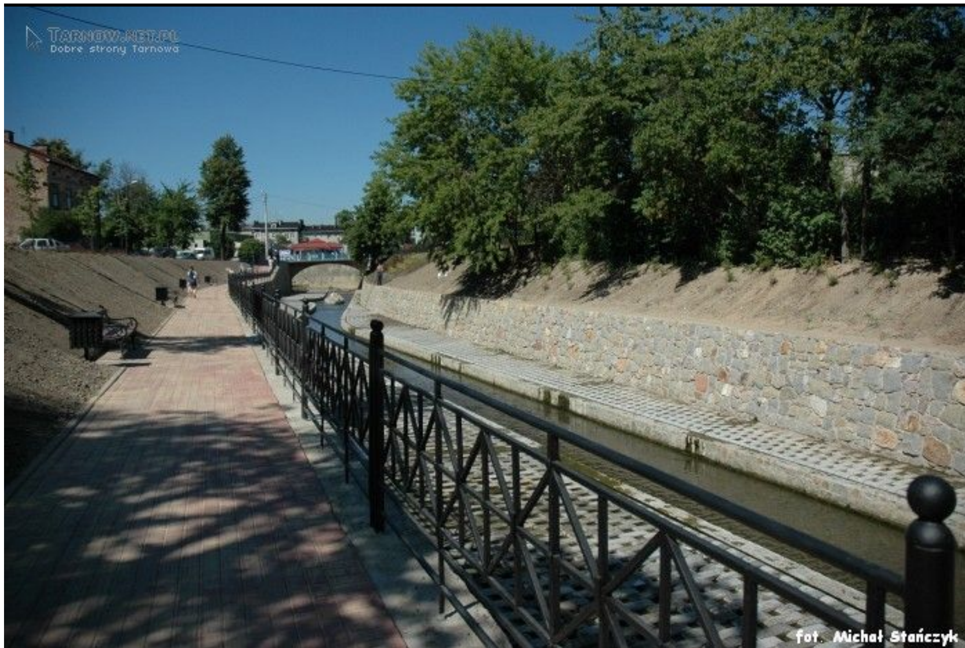
Bulwary nad W tokiem, 2006. Koszt inwestycji 1 500 000 zł. Wkład miasta: 500 000 zł, dofinansowanie z rządowego programu ochrony przeciwpowodziowej: 1 000 000 zł.
